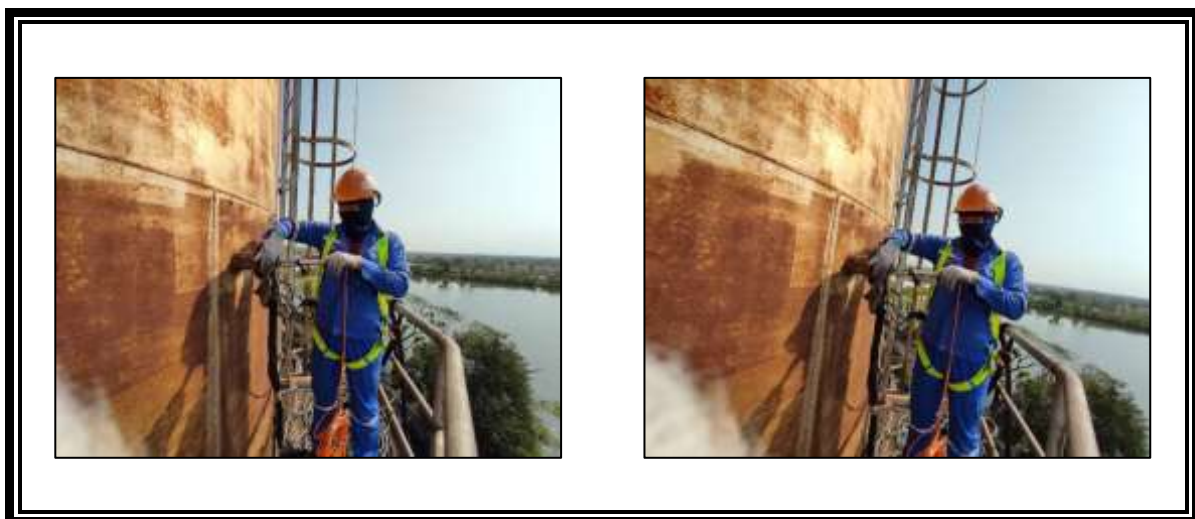
รูปที่ 3.3-2 จุดตรวจวัดคุณภาพอากาศจากปล่องปล่อยทิ้งอากาศเสีย บริเวณหม้อไอน้ำ ชุดที่ 2 ในวันที่ 23 กุมภาพันธ์ พ.ศ. 2566
