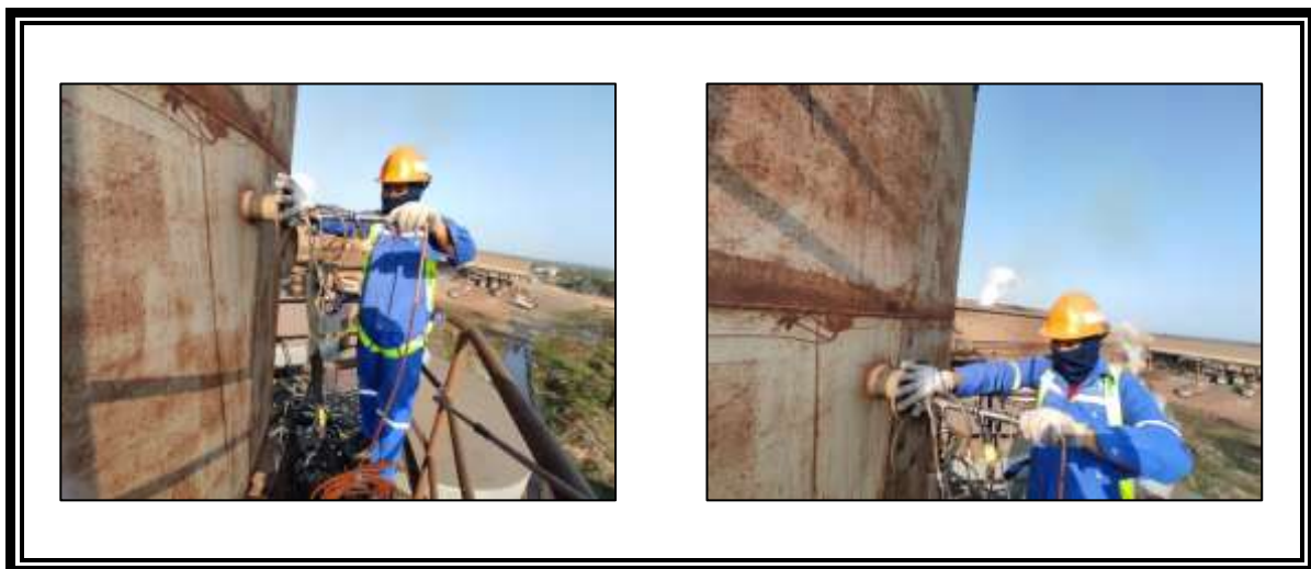
รูปที่ 3.3-1 จุดตรวจวัดคุณภาพอากาศจากปล่องปล่อยทิ้งอากาศเสีย บริเวณหม้อไอน้ำ ชุดที่ 1 ในวันที่ 23 กุมภาพันธ์ พ.ศ. 2566
