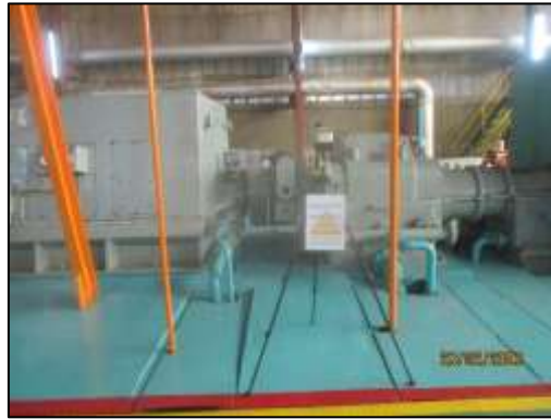
บริเวณพื้นที่เครื่องผลิตไฟฟ้า แบบกังหันไอน้ำ
